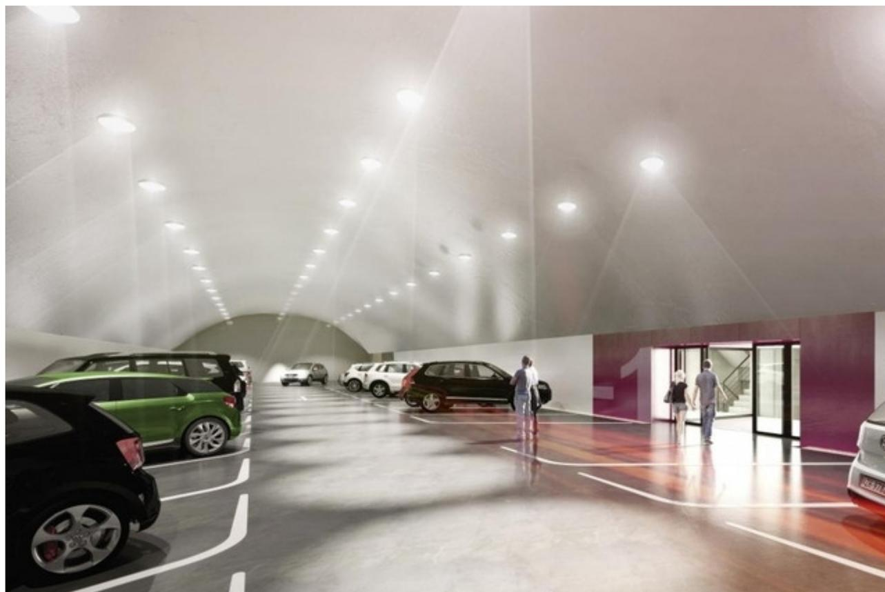
So soll das Parking im Thuner Schlossberg aussehen: Das Projekt der Marti Tunnelbau AG sieht eine Konstruktion ohne Stützpfiler vor. Eine Fräsmaschine holt eine Kaverne aus, anschliessend werden vier Parkdecks eingebaut.
